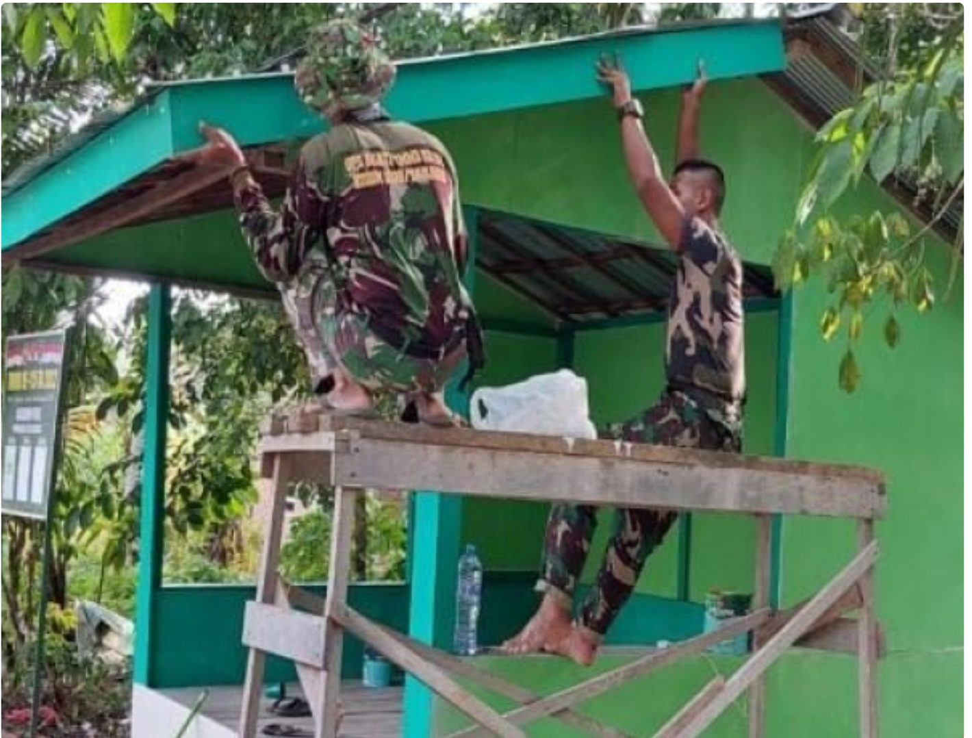
Satgas Poles Cat Hijau Perindah Pos Kamling Program TMMD ke-115
