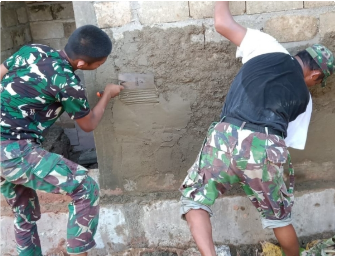
Satgas TMMMD ke-115 Kodim 1098/Tabalong Plester Dinding Mushola Nurul Iman
