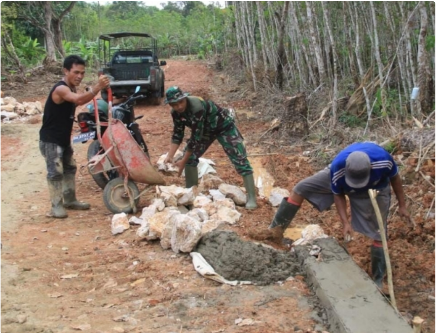
Pembuatan Badan Jalan Sepanjang 1020 meter Capai 45 Persen
