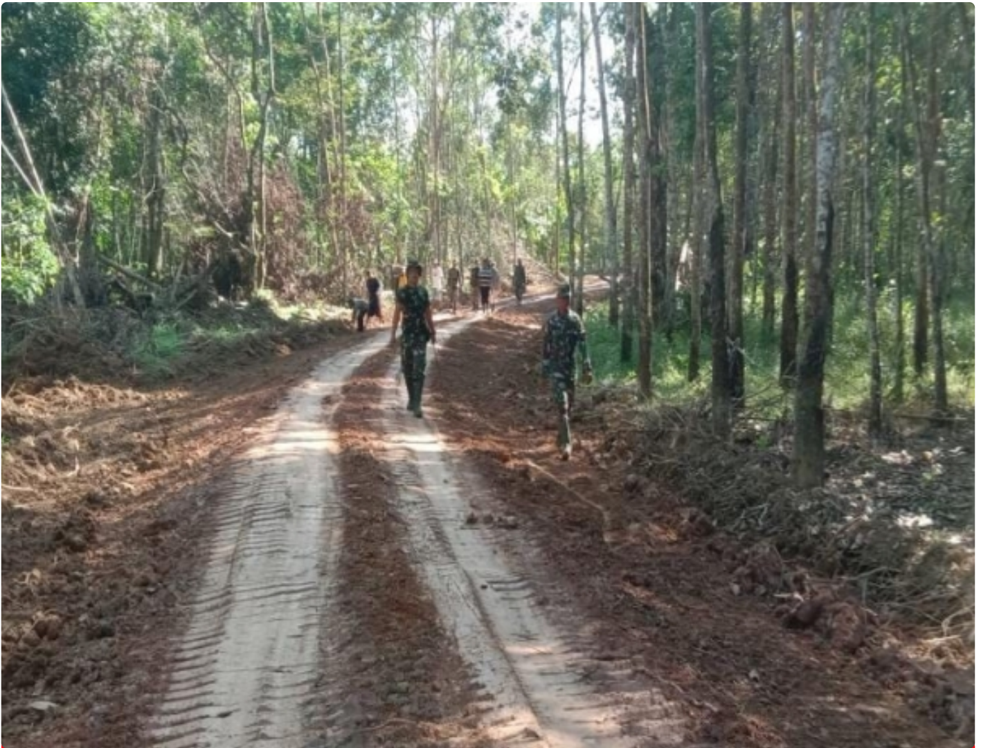
Jalan Penghubung Program TMMD ke-115 Kodim Tabalong Menjadi Solusi Kesulitan Warga
