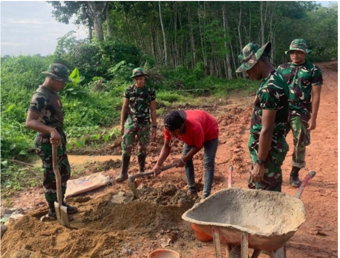
Anggota Satgas dan Warga Bahu Membahu Selesaikan Pemasangan Gorong-gorong
