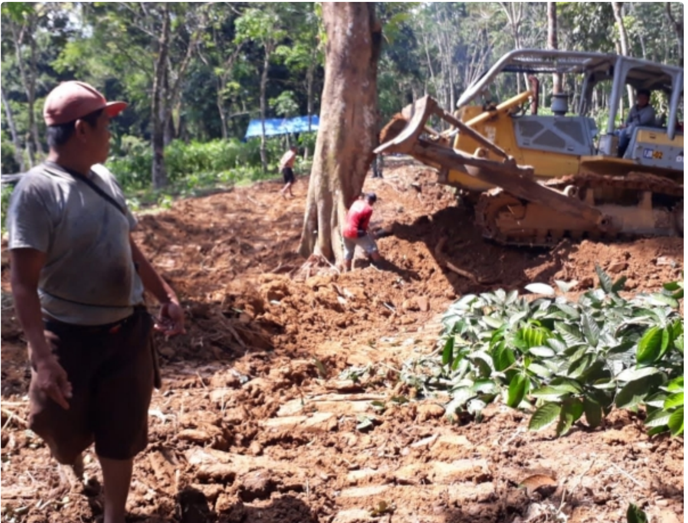
Alat Berat Diturunkan, Pembuatan Badan Jalan TMMD ke-115 Kodim 1008/Tabalong
